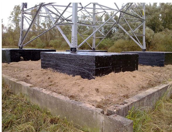
Rys. 3. Przykład fundamentu słupa energetycznego wysokiego napięcia 110 kV
