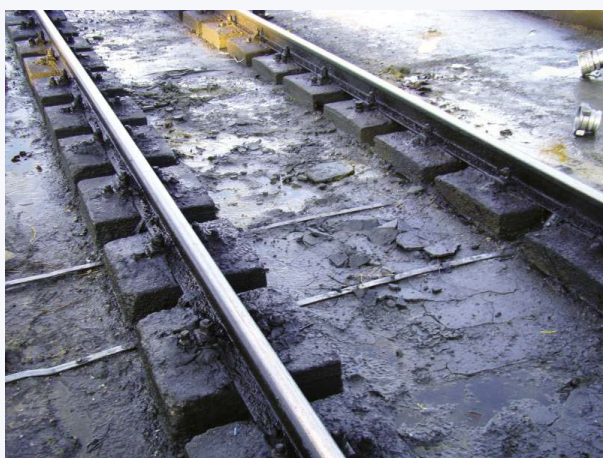
FOT. 2. Tor z płytą podtorza: uszkodzenia części głównej podtorza; fot. : archiwa autorów
