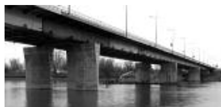
Fot. 2. Odbudowany most Łazienkowski
