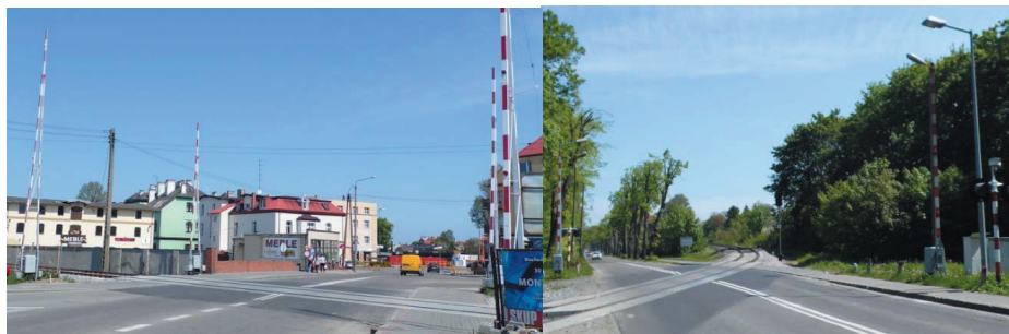
Rys. 3. Przejazd kat. A (po lewej) i przejazd kat. B (po prawej) na linii nr 213 Reda – Hel [10]
