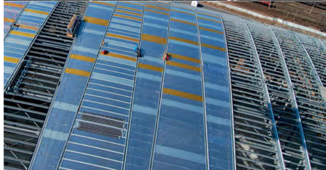
Rys. 1. Przykłady dowolnego kształtowania bryły obiektów z lekką obudową (fot. D. Kowalski) a) obiekt wysoki kubaturowy, b) przekrycie wejścia do pasażu podziemnego, c) fasada ściana i przekrycie dachowe zadaszenia obiektu sportowego [4, 6, 7]
