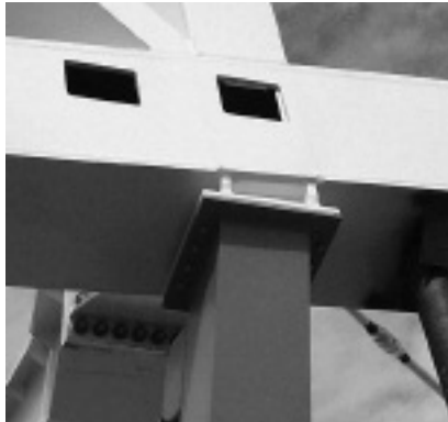
Fot. 2. Połączenie dźwigara dachowego ze słupem
