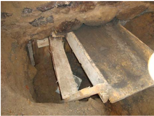
Ryc. 3. Podbicie fundamentów: a) przygotowanie do odcinkowego podbicia, b) widok podbitych fundamentów
