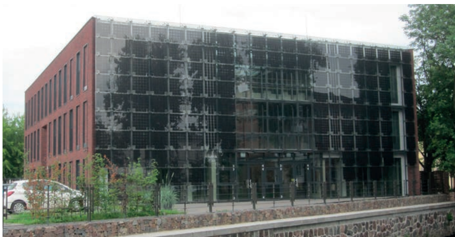
Fot. 5. Szklana fasada z ogniwami fotowoltaicznymi
