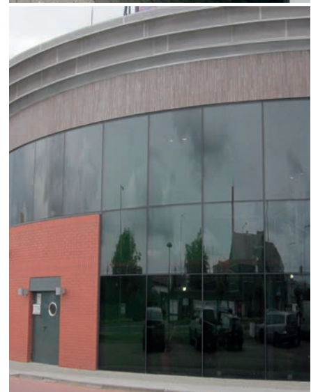
Fot. 4. Szklana fasada wykonana ze szkła giętego
