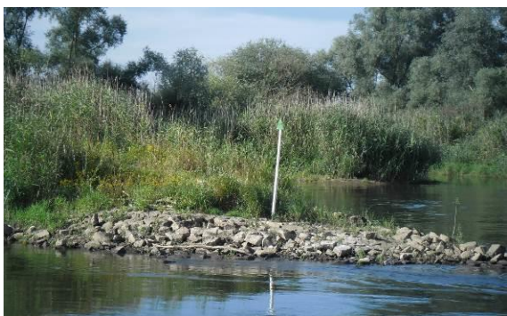
Rys.2 Budowla regulacyjna na Odrze [fot. Sobkowicz P.]
