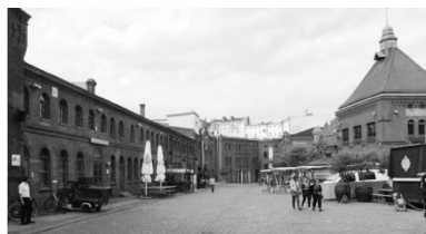
Fot. 12. Dawny browar przy Schonhauser Allee, obecnie centrum kulturalno-rozrywkowe, KulturBrauerei [ www.kulturbrauerei.de ], Berlin, Prenzlauer Berg
