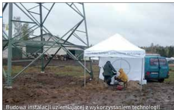
Budowa instalacji uziemiającej z wykorzystaniem technologii
