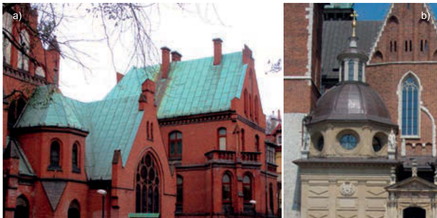
Rys. 5. Przykłady zastosowania blachy miedzianej na obiektach sakralnych: a) Gdańsk, b) Kraków
