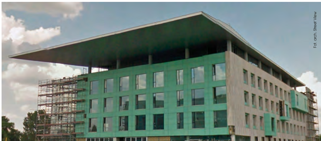
Rys. 7. Budynek użyteczności publicznej Warszawa Wilanów – okładzina miedziana wstępnie patynowana
