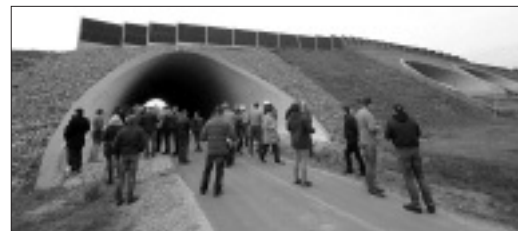
Wycieczka techniczna na budowę drogi S5 – Poznań – Wrocław. Obiekty inżynierskie w technologii konstrukcji podatnych z blach falistych [Fot. archiwum ViaCon Polska]
