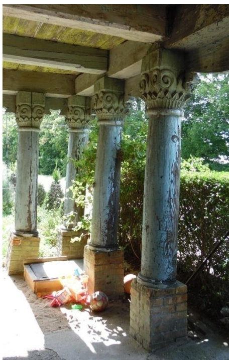
Fot. nr 4 Dom podcieniowy w Bystrzu. (fot. Autor)
