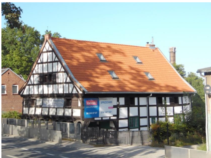
Fot. nr 1 Dom podcieniowy w Gdańsku Lipcach, typ I. (fot. Autor)
