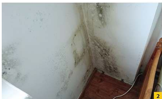
FOT. 1-3. Uszkodzenia ciepłno-wilgotnościowe w pokoju przyległym do ściany szczytowej (PS) w lokalu mieszkalnym w poziomie kondygnacji XI piętra budynku; fot.: archiwum autora
