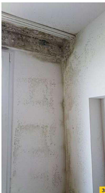
FOT. 1-3. Uszkodzenia ciepłno-wilgotnościowe w pokoju przyległym do ściany szczytowej (PS) w lokalu mieszkalnym w poziomie kondygnacji XI piętra budynku; fot.: archiwum autora
