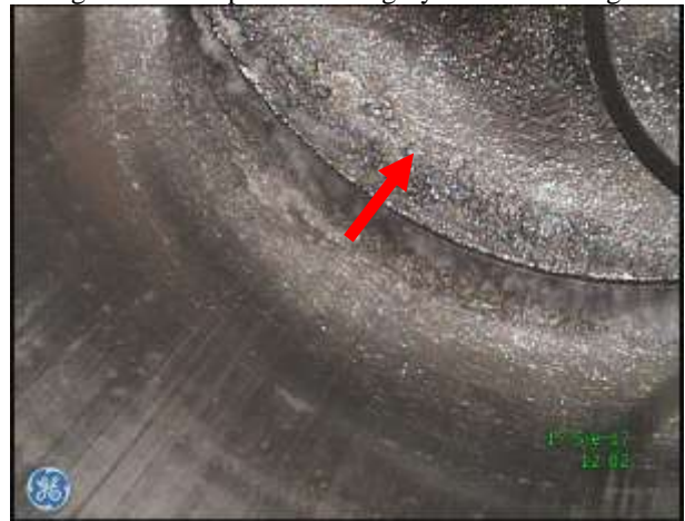
d) Przestrzeń robocza w rejonie GMP tłoka – osady nagaru na dolnej płycie głowicy
