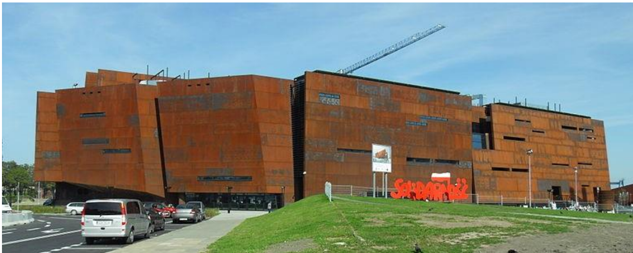
Fot. 13 – arch. W. Targowski – Budynek ECS (2014), Gdańsk – (Fot. Artur Andrzej )
