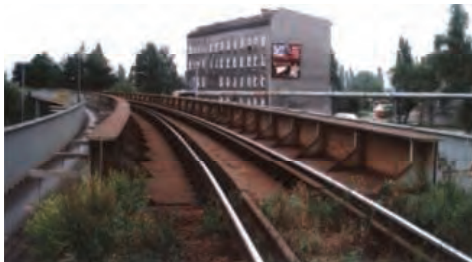
1. Wiadukt blachownicowy z pomostem stalowym bez podsypki
