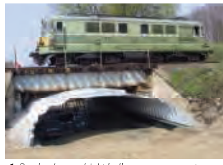
1. Przebudowa obiekt belkowego na gruntowo-powłokowy
