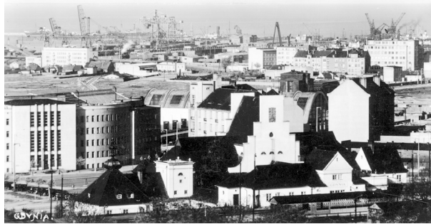
Fot. 8. W drugiej połowie lat 30. XX w., śródmieście Gdyni w swoim wizerunku miało już w pełni wielkomiejski charakter, czego dowodem jest pocztówkowa panorama miasta i portu w widoku od strony dworca kolejowego z 1938 r.
