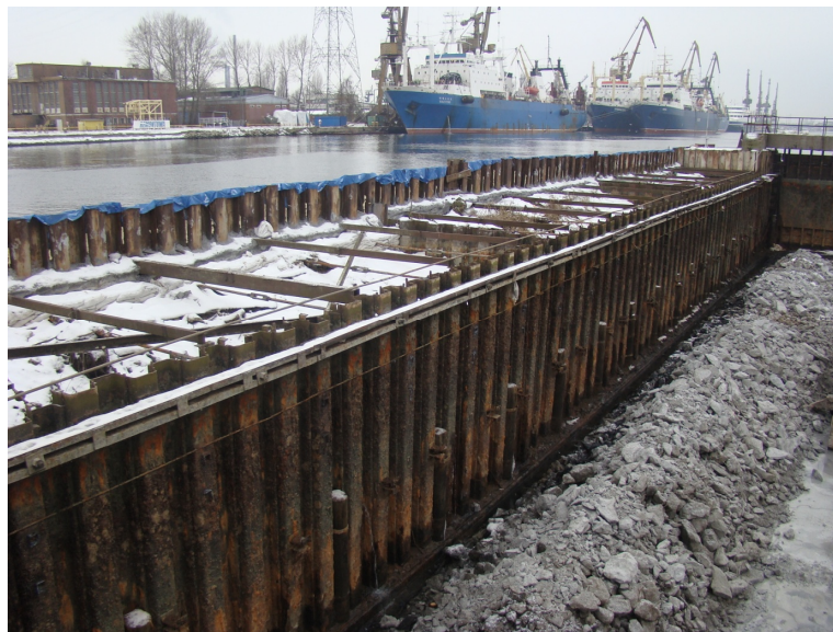
Rys. 3 - Widok komory zachodniej doku i grodzy zewnętrznej grodzy od strony kanału po rozpoczęciu rozkuwania płyty dna doku. Fot. własna
