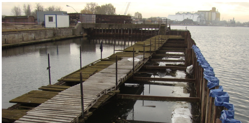
Rys. 2 - Widok komory wschodniej doku i grodzy zewnętrznej od strony Kanału oraz bramy wschodniej doku i Nabrzeża Przemysłowego przed rozpoczęciem robót rozbiórkowych. Fot. własna
