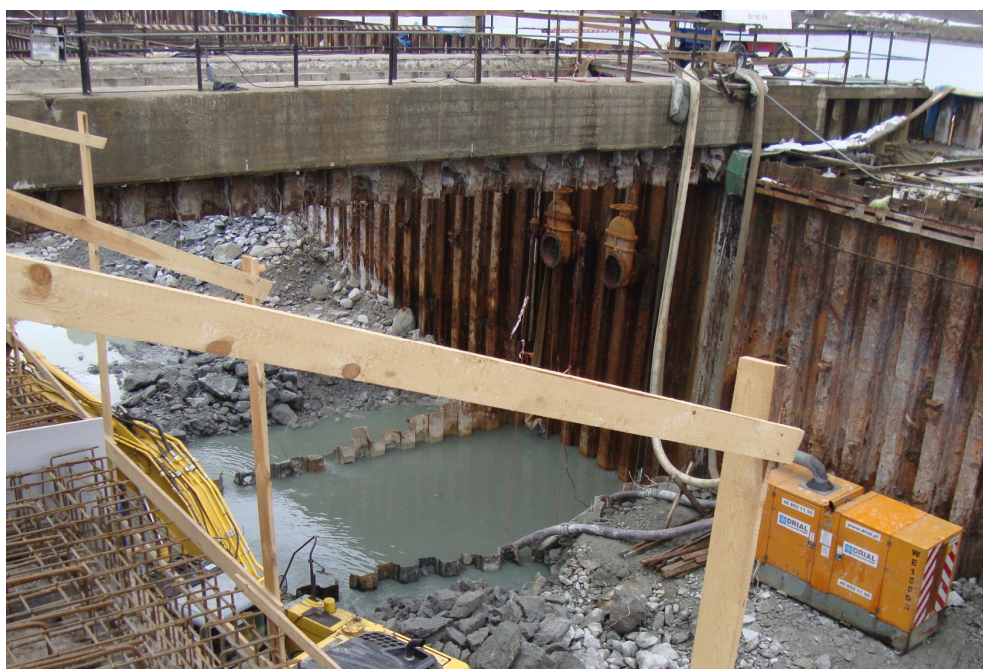
Rys. 10 - Widok komory pomp po wycięciu ścianek szczelnych do poziomu dna grodzy wykorzystywanej, jako duża studnia odciążająca po udroźnieniu jej dna. Fot. własna
