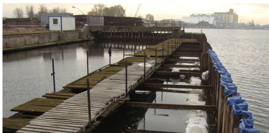
Rys. 2 - Widok komory wschodniej doku i grodzy zewnętrznej od strony Kanału oraz bramy wschodniej doku i Nabrzeża Przemysłowego przed rozpoczęciem robót rozbiórkowych. Fot. własna
