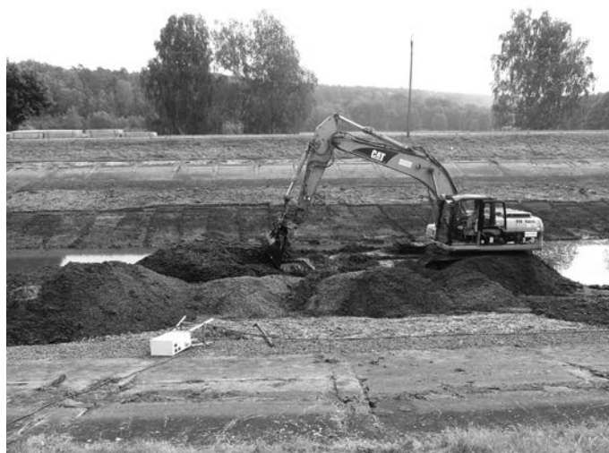
Rys. 3. Czyszczenie kanału z omułków i innych zanieczyszczeń 11.08.2014 roku (fot. W. Sterpejkowicz-Wersocki)
