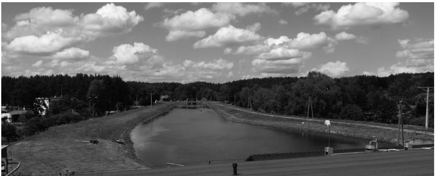
Rys. 1. Widok ogólny kanału przed remontem – lipiec 2014 roku (fot. W. Sterpejkowicz-Wersocki)
