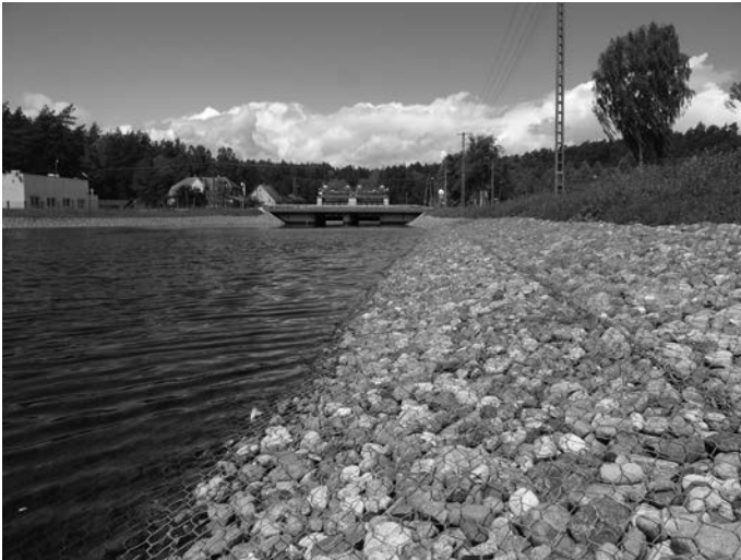
Rys. 9. Kanał derywacyjny po zakończeniu robót renowacyjnych (fot. W. Sterpejkowicz-Wersocki)
