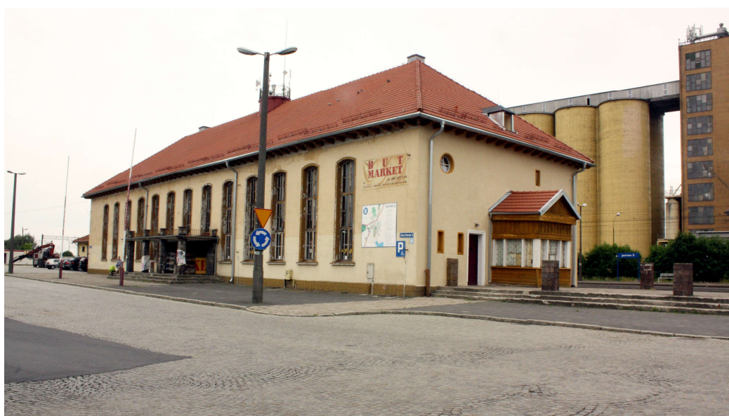
Fot.4. Dworzec w Olsztynku. Przeznaczony do przebudowy w latach 2017-2018. Przed modernizacją.
