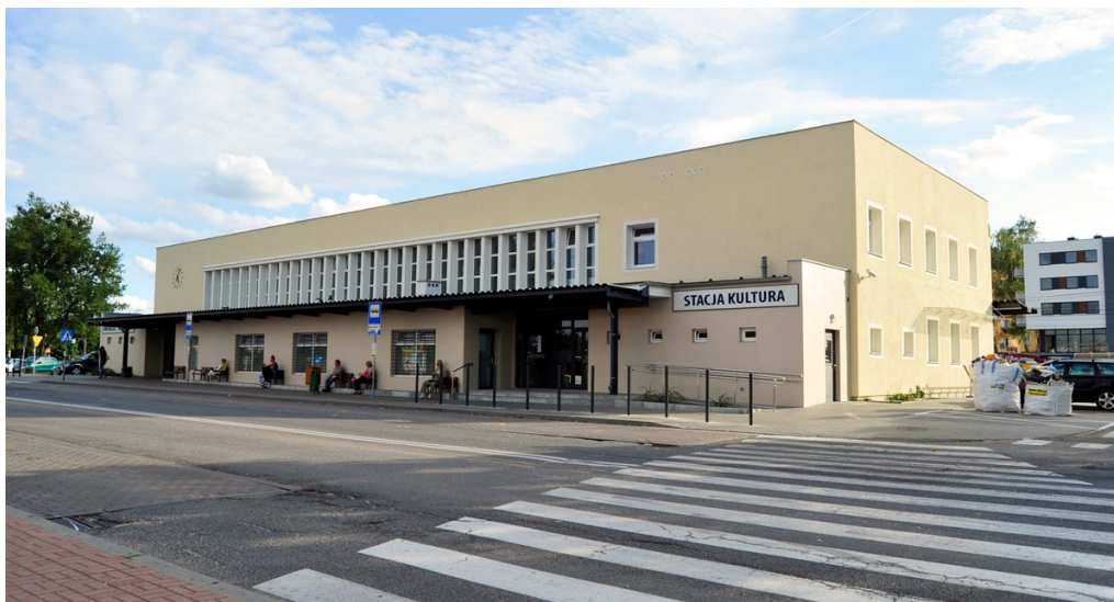
Fot.3. Dworzec w Rumi zmodernizowany w 2014 r. nie objęty żadną formą ochrony konserwatorskiej.
