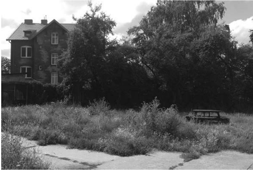
Ryc. 6. Podwórkę przy ulicy Związkowej 4 i 6 - cztery lata po zakończeniu prac – lato 2017
