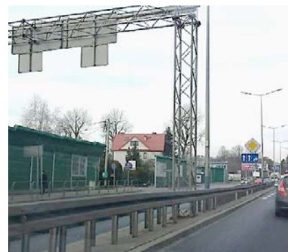
Fot. 1. Konstrukcja wsporcza w szerokości pracującej bariery
