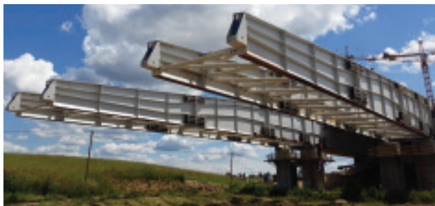
Fot. 2. Zastosowane dzioby montażowe w trakcie nasuwania obiektu [Fot. K. Żółtowski] Photo 2. Used launching noses during incremental launching process
