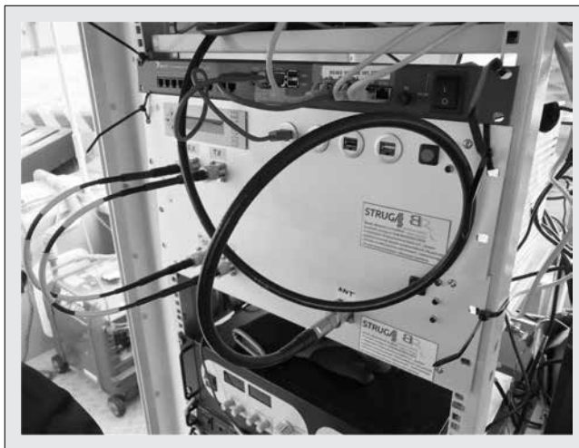
■ Rys. 7. RTU na stanowisku badawczym podczas badań testowych na morzu
