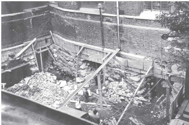
Il. 7. Rozbiórka piwnic z XVI w. w celu budowy kotłowni w 1929 r. Na ścianie nawy północnej widoczny zarys skutych koleb piwnicy (z zasobu Archiwum Państwowego w Gdańsku, [15])
