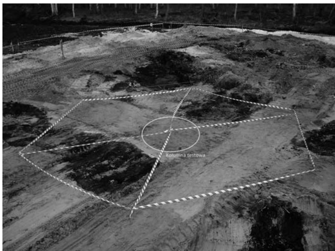
Rys. 4. Kolumna badana w otoczeniu sześciu kolumn wzmocniających
