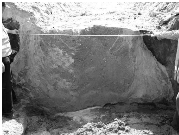
Rys. 2. Podstawa kolumny z kruszywa
