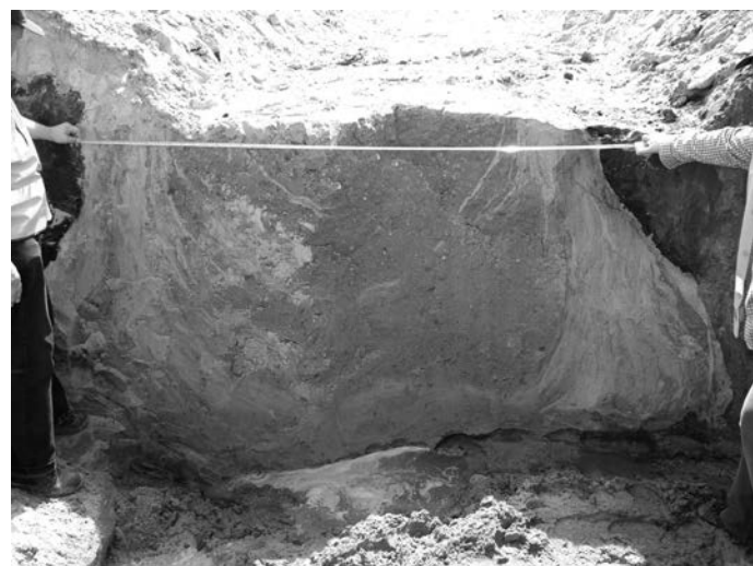
Rys. 2. Podstawa kolumny z kruszywa
