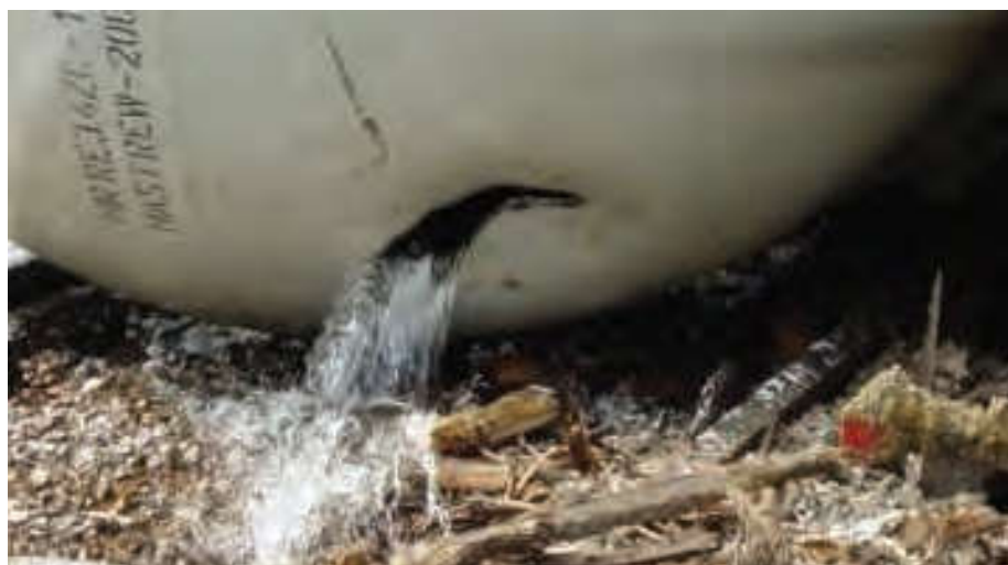
2. Negatywny wpływ katastrofy kolejowej na podtorze. Katastrofa w Szczygłowicach 23.05.2002 [10]
