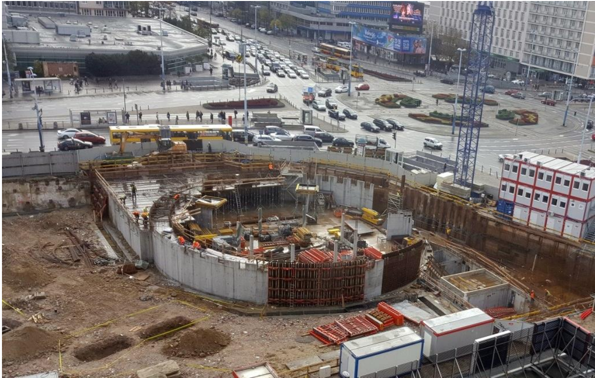
Rys. 15. Podziemna, żelbetowa część nowej Rotundy nabiera kształtów
