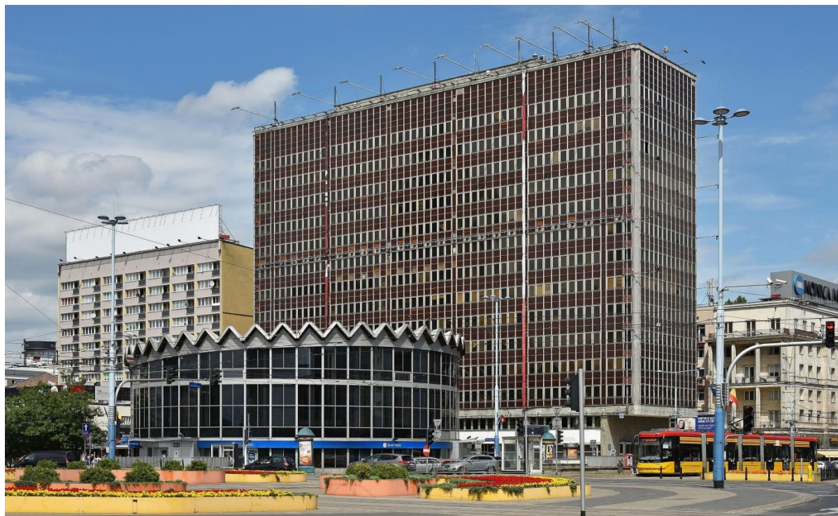
Rys. 1. Warszawska Rotunda PKO BP i budynek dawnego Uniwersalu w pełnej krasie na chwilę przed początkiem rozbiórki obu obiektów – rok 2016
