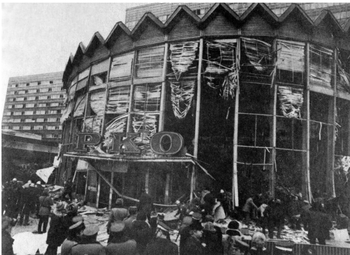
Rys. 5. Rok 1979 - zniszczenie obiektu na skutek wybuchu
