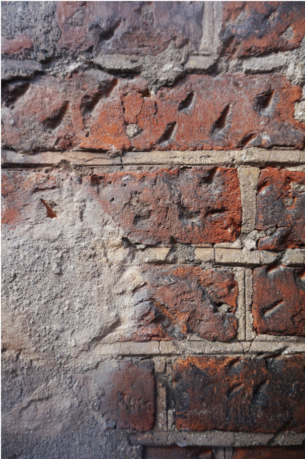
Il. 4. Fragmenty zachowanego tynku i nasieki na ceglach na ścianie południowej transeptu kościoła Mariackiego w Gdańsku – relikty po zegarze słonecznym wschodnim przy środkowym oknie (fot. A. Piwek, 2018)
