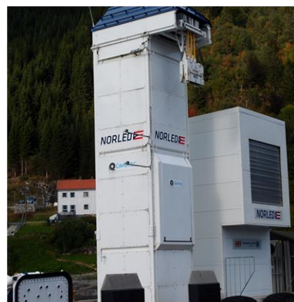
Rys. 3. Dwa systemy ładowania nabrzeżnego promu „Ampere”
