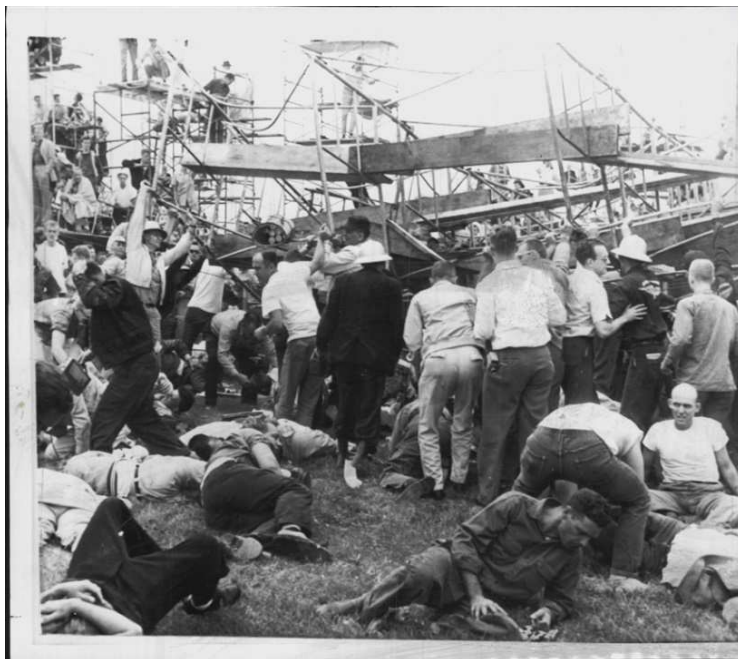
Fot. 1.2 Awaria trybuny metalowej wznoszonej za pomocą systemu rusztowań w Indianapolis w 1960 roku ( http://indymotorspeedway.com ).
