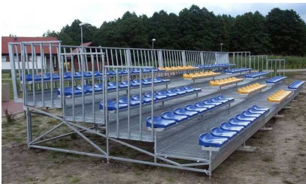
Fot. 2.2 Metalowa trybuna demontowalna ( www.trybunysportowe.pl ).
