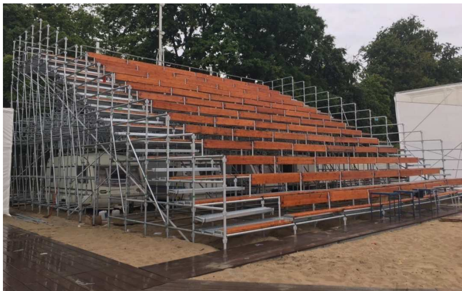
Fot. 6.1 Tymczasowa trybuna stalowa (widok z boku).
