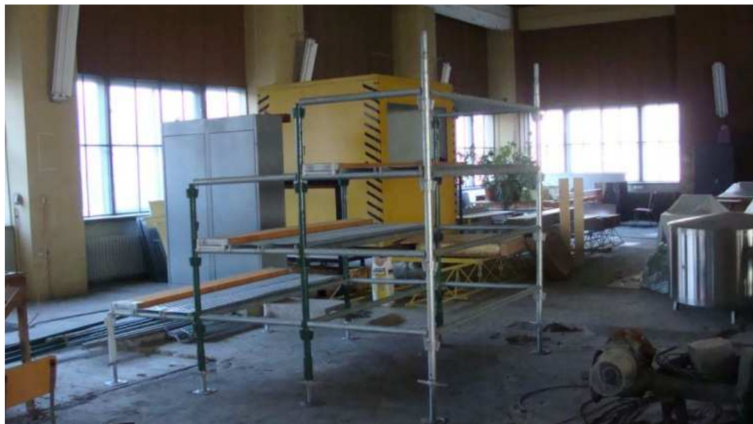
Fot. 5.2 Pusta tymczasowa trybuna stalowa (widok z tyłu).
