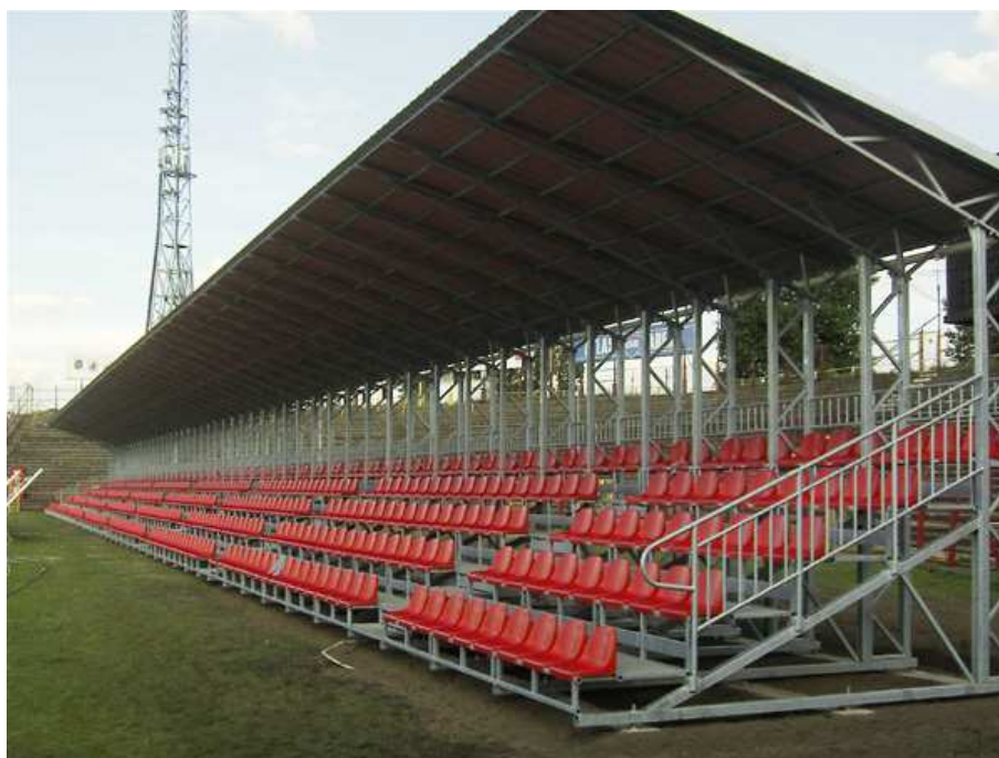
Fot. 2.6 Trybuna metalowa z zadaszeniem (www.wamat.com.pl).
