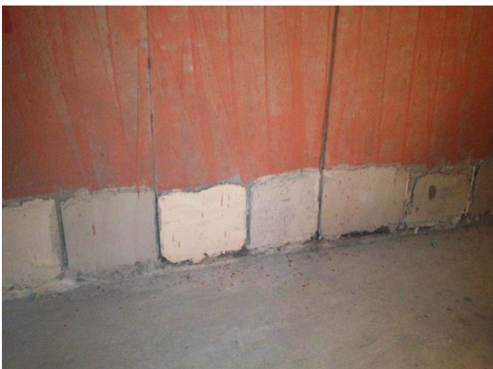
FOT. 2. Widok próbek (poetek tynkarskich) wykonanych na ścianie żelbetowej (podłoże betonowe); fot.: autorzy Z uwagi na edukacyjny i niekomercyjny charakter badań eksperymenty przeprowadzono w oparciu o minimalną miarodajną liczbę testów określoną w normie i wynoszącą 3. Powierzchnia krążków po badaniu każdorazowo podlegała oczyszczeniu za pomocą przyrządu do szlifowania, odtłuszczeniu i osuszeniu.
