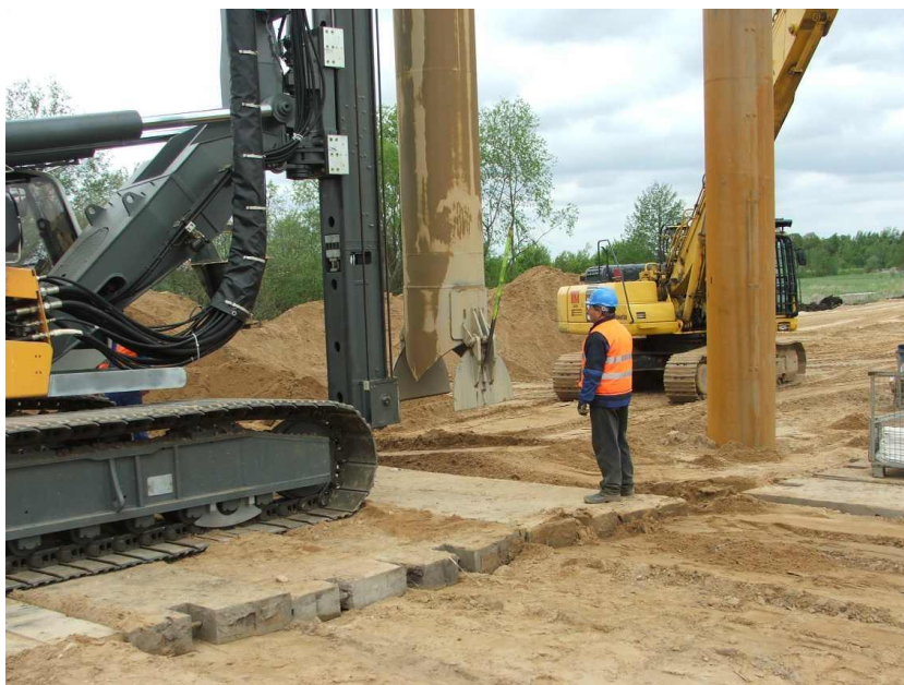
Fotografia 1.2 Platforma robocza na budowie Autostrady A-2 odcinek Łągów – Jordanowo
