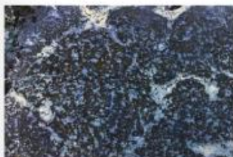
FOT. 11. Widok struktury porów tynku ciepłochronnego (perlitowego); fot.: autorzy
