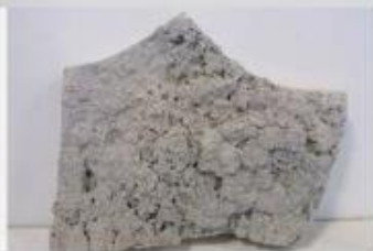
FOT. 5. Widok próbki tynku od strony tynku ciepłochronnego (perlitowego); fot.: autorzy
