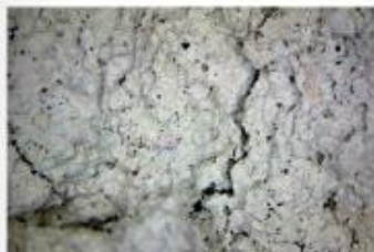
FOT. 8. Struktura tynku – widok tynku ciepłochronnego (perlitowego); powiększenie 20-krotne; fot.: autorzy
