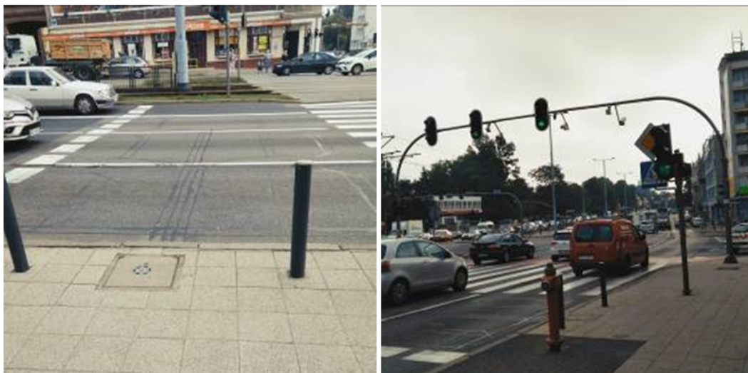
Rysunek 2.5: Widoczne cięcia po wprowadzeniu pętli indukcyjnych (para na każdy pas ruchu - (po lewej) wraz z wyprowadzeniem połączeń fiderem prowadzącym sygnały do detektora, urządzenia VIP wraz z oświetlaczem (po prawej)
