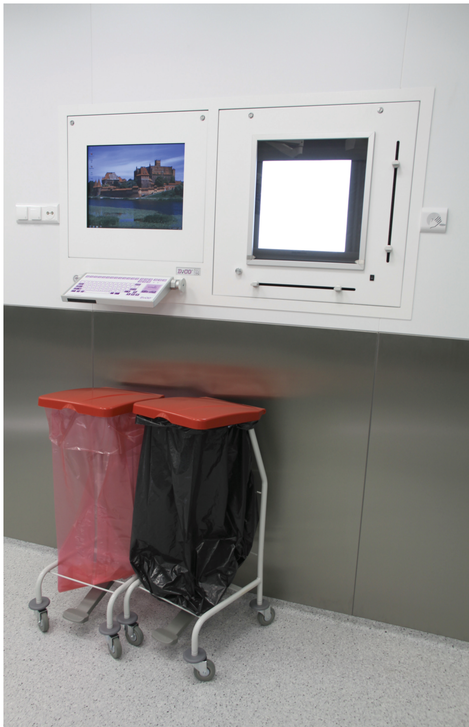
Ilustracja 6.3.2.4 Monitor z klawiaturą na sali operacyjnej (elementy wyposażenia wykonane w sposób umożliwiający systematyczne przeprowadzanie procesu dezynfekcji), fot. autor, 2015 r.
