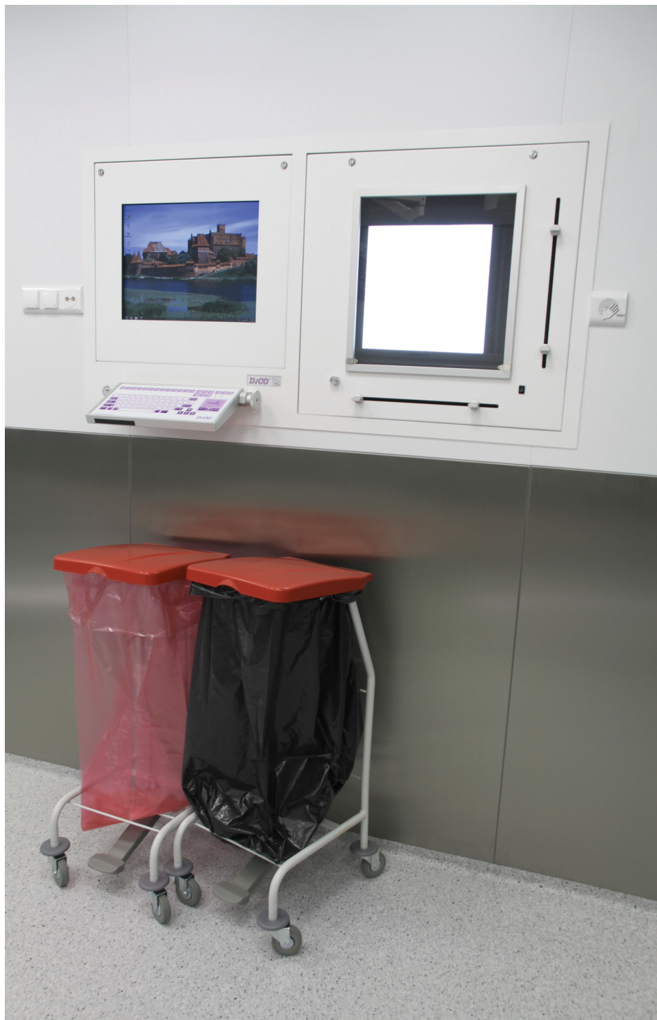
Ilustracja 6.3.2.4 Monitor z klawiaturą na sali operacyjnej (elementy wyposażenia wykonane w sposób umożliwiający systematyczne przeprowadzanie procesu dezynfekcji), fot. autor, 2015 r.
