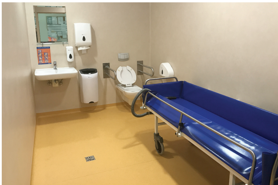
Ilustracja 2.0.1 Wózek-wanna – stanowisko mycia pacjenta (rozwiązanie umożliwiające wykonanie procedur higienicznych np. dekontaminację pacjenta podczas przyjęcia w obszarze SOR), fot. autor, 2016 r.
