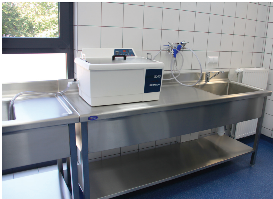
Ilustracja 2.1.2 Pomieszczenie sterylizacji (właściwe przygotowanie materiału do sterylizacji wymaga przeprowadzenia szeregu czynności), fot. autor, 2016 r.
