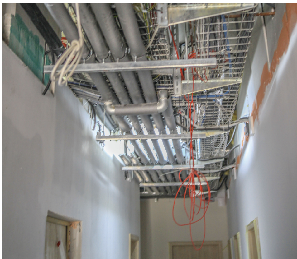
Ilustracja 3.1.1 Korytarz (infrastruktura techniczna we współczesnym szpitalu to rozbudowana struktura wymagająca analizy ryzyka HAI), fot. autor, 2014 r.
