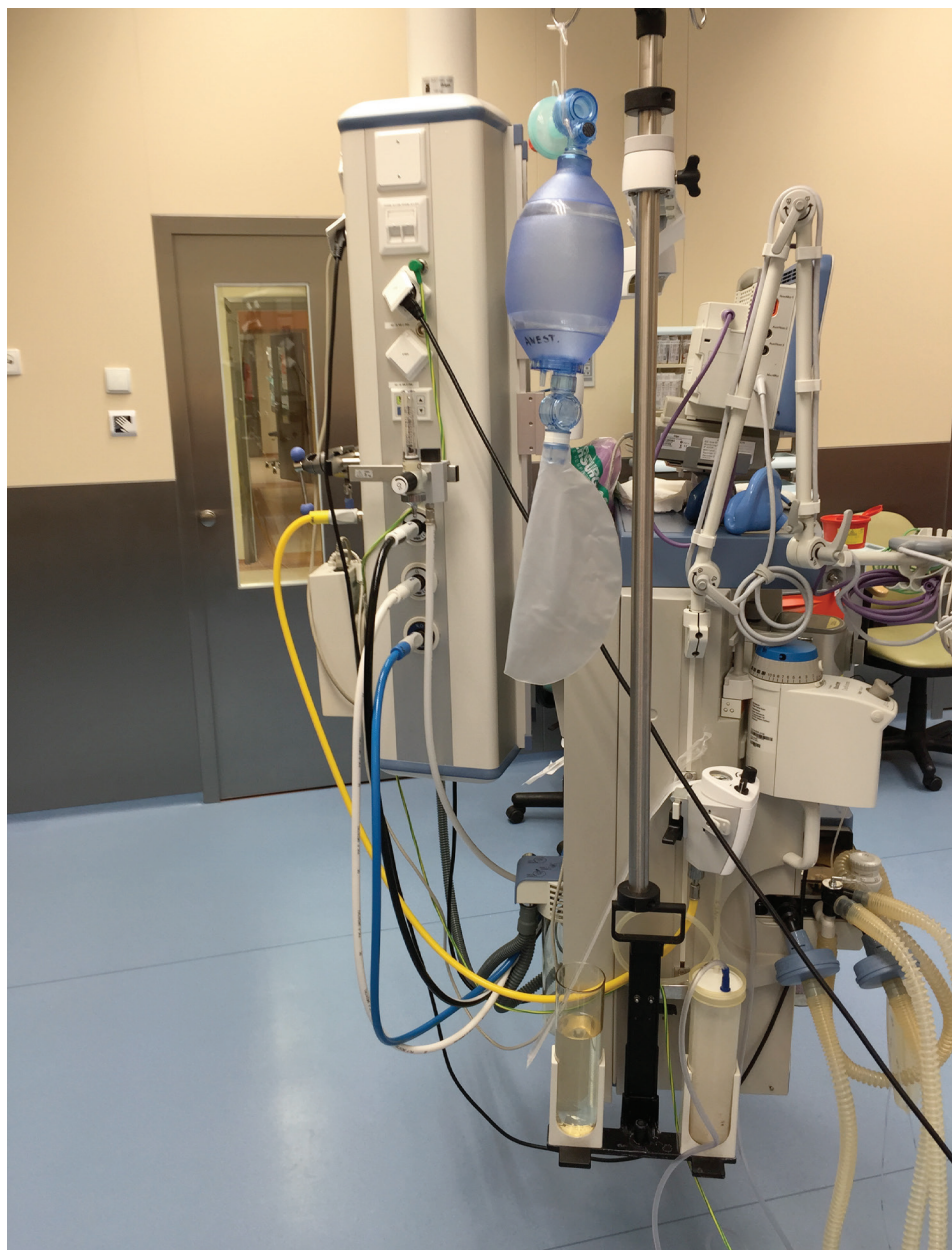
Ilustracja 6.2.3.6 Wyposażenie sali operacyjnej (możliwość podwieszenia wyposażenia na podwieszanej kolumnie ułatwia dezynfekcję podłóg), fot. autor, 2016 r.
