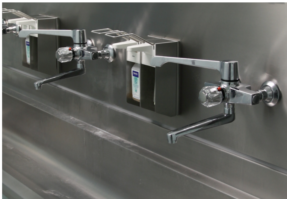
Ilustracja 6.3.1.5 Łokciowa bateria umywalkowa (przykład uruchamiania wyposażenia higienicznego bez udziału rąk personelu), fot. autor, 2016 r.
