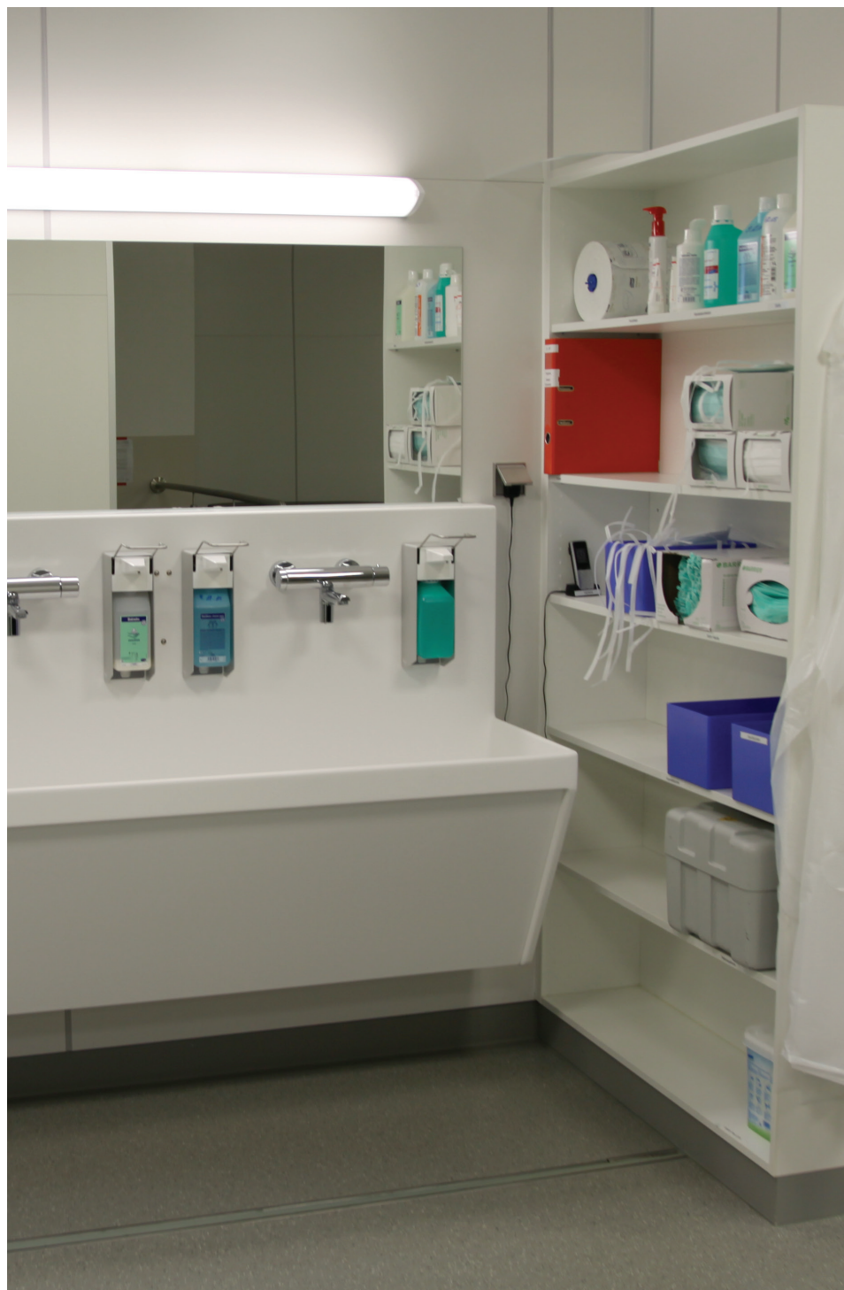
Ilustracja 4.1.2 Stanowisko higieny rąk w komunikacji bloku operacyjnego (przykład rozwiązania wykluczonego przez polskie przepisy prawa i spotykanego w innych krajach), fot. autor, 2015 r.
