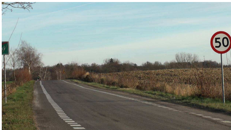
Rys. 7. Ilustracja fotograficzna odcinka „A”, w rejonie przekroju pomiarowego nr 1 w ciągu badanej drogi powiatowej nr 2628G.
