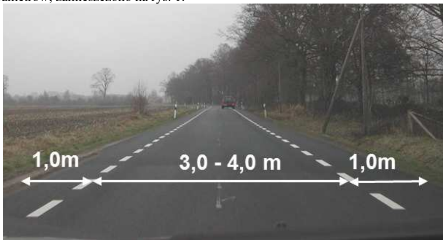
Rys. 1. Ogólny schemat przekroju drogowego typu „2 minus 1” [4].
