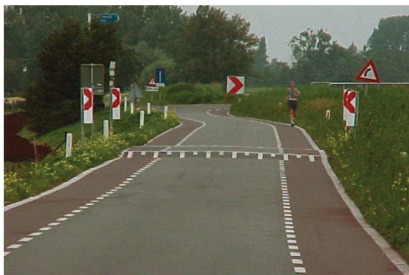
Rys. 4 Ilustracja fotograficzna przedstawiająca drogę o przekroju „2 minus 1” funkcjonującą w rejonie miejscowości w Zoetermeer w Holandii [4].
