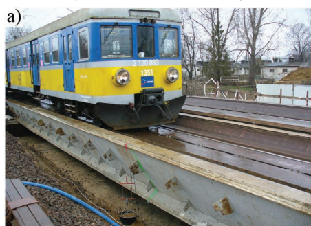
3. Przęsło odciążające KO30: (a) konstrukcja wbudowana w torze 502 PKP SKM podczas badań eksploatacyjnych, (b) wizualizacja modelu numerycznego przęsła (SOFISTIK)
