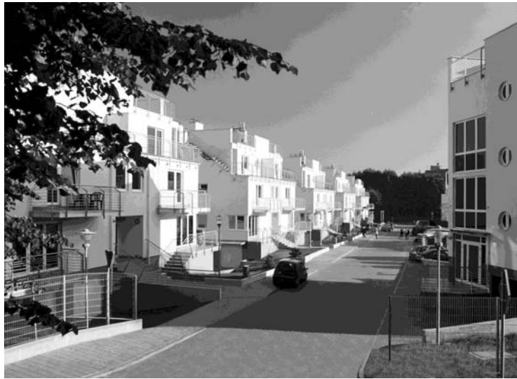
Fot. 2. Zespół zabudowy mieszkaniowej w Gdyni Orłowice
