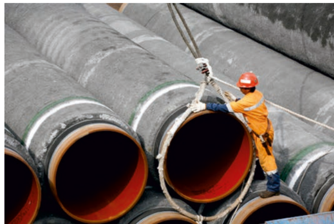
Rys. 6. Rury wielkośrednicowe, każda o długości 24 m – tak zwane dublety, średnicy wewnętrznej D_i = 1,2192 m (48 cali) i grubości ścianki stalowej t = 38,1 mm (1,5 cala), wykorzystane do budowy gazociągu „Nord Stream”, ułożonego na dnie Morza Bałtyckiego [37]
