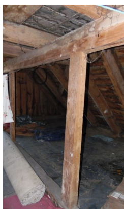
Fot. 8. Marynowy –ściana stolcowa podpierająca jętkę (fot. autor)
