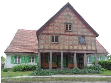
Fot. 13. Dom podcieniowy w Lubieszewie (fot. autor)
