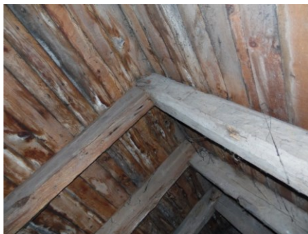
Fot. 9. Nowa Kościelnica – połączenie krokwi. (fot. autor)
