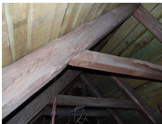
Fot. 11. Rybina – więźba dachowa. (fot. autor)
