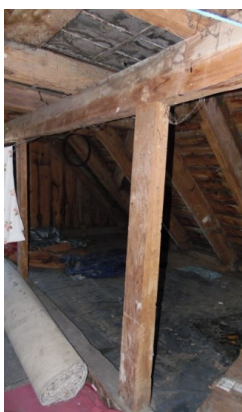
Fot. 8. Marynowy –ściana stolcowa podpierająca jętkę (fot. autor)
