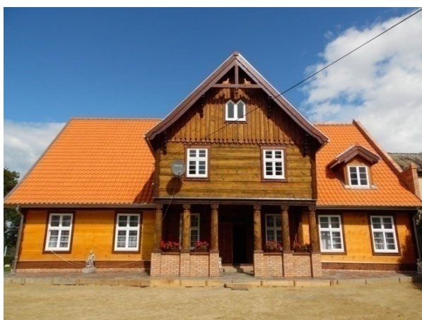
Fot. 4. Dom podcieniowy w Rybinie. (fot. autor)
