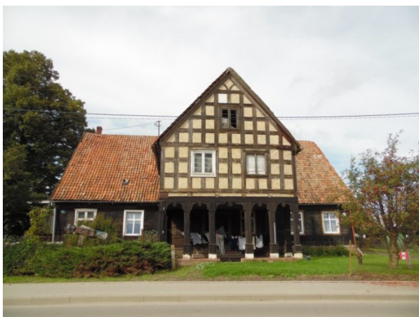
Fot. 2. Dom podcieniowy w Marynowo. (fot. autor)
