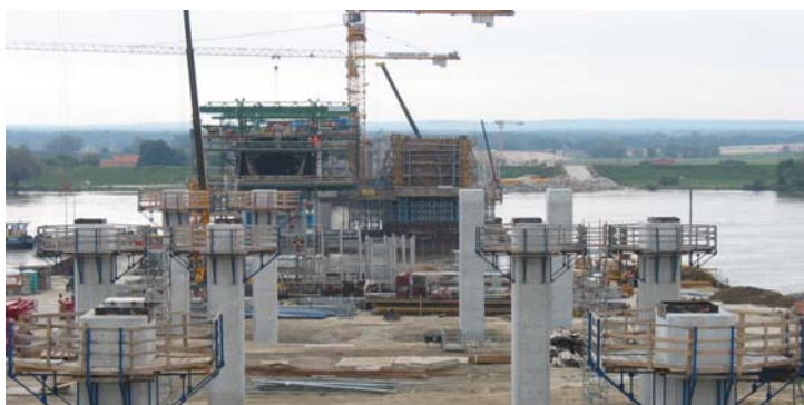
Rysunek 8. Budowa mostu przez Wisłę w ciągu autostrady A-1 w Grudziądzu.
