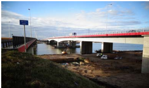
Rysunek 4. Most przez Wisłę w ciągu drogi S-7.
