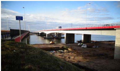
Rysunek 4. Most przez Wisłę w ciągu drogi S-7.
