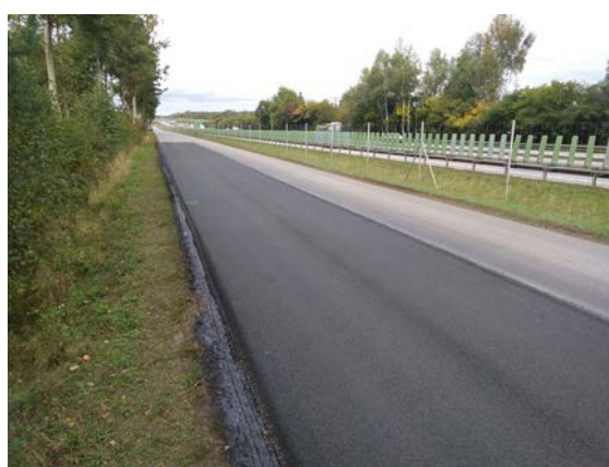
Figure 19. Galaktyczna test section after completion.
