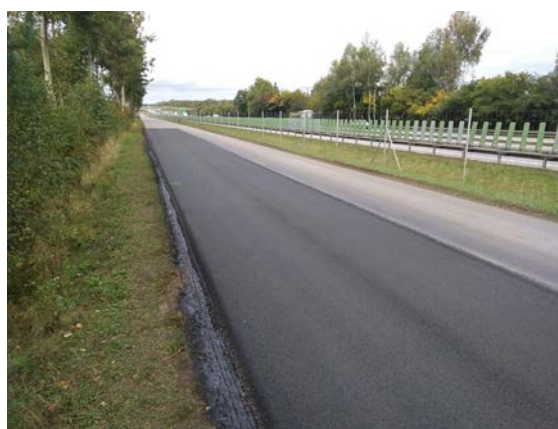
Figure 19. Galaktyczna test section after completion.
