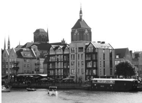
Fot. 10. Widok na zespół kamienic przy Targu Rybnym (Immo Lux)
