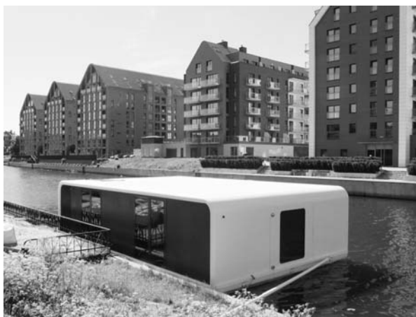
Fot. 12. Pierwszy w Gdańsku nowoczesny „dom na wodzie” zacumowany przy nabrzeżu Nowej Motławy
