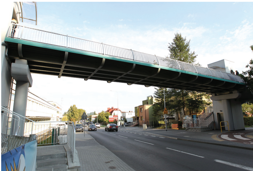
Rys. 4. Widok z boku kładki nad ulicą Chwarznieńską w Gdyni
