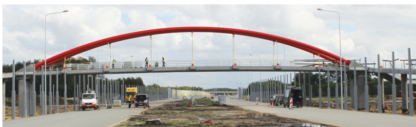
Rys. 2. Widok z boku kładki nad drogą S8
