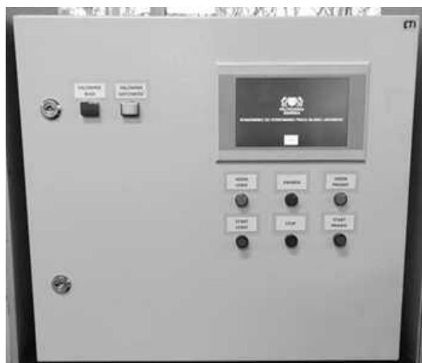
Rys. 5. Widok elewacji szafy sterowniczej
