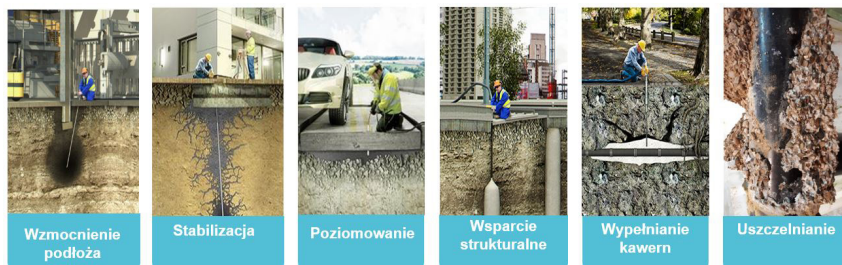
Fot. 3. Zastosowanie iniekcji geopolimerowych (Geobear Sp. z o.o.)
